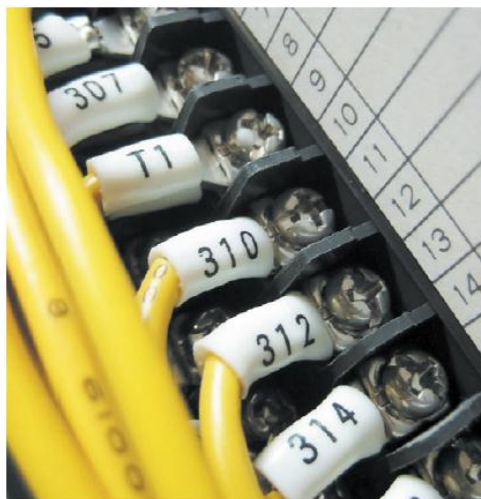
Рисунок 10 – Подсоединение проводов к контактам при помощи наконечников
