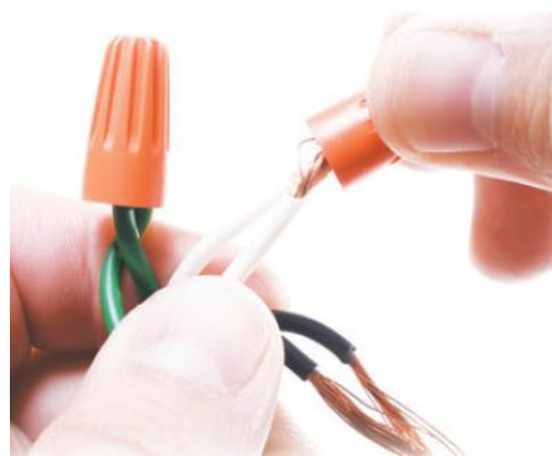
Рисунок 13 – Соединение жил при помощи скруток-колпачков
